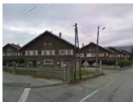
Maisons ouvrières du Clos Champin - Route de Condrieu
