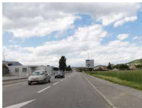
RD 4 en centre-village et en entrée Sud du centre-village
