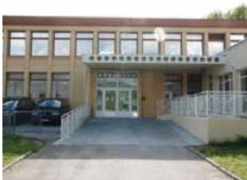
Ecole publique des Grouillères
