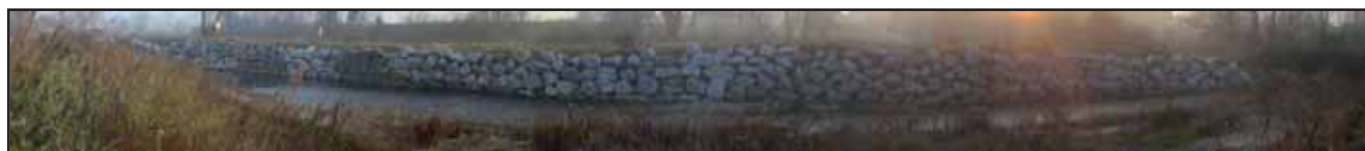
Confortement de berge en enrochements secs
