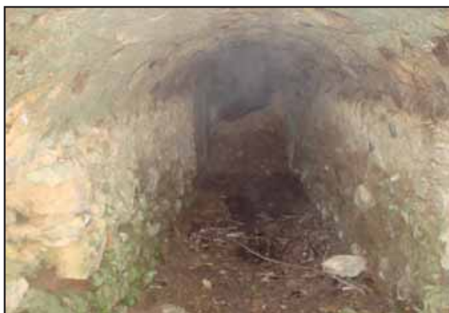
Source de la Madone, galerie d'amenée
