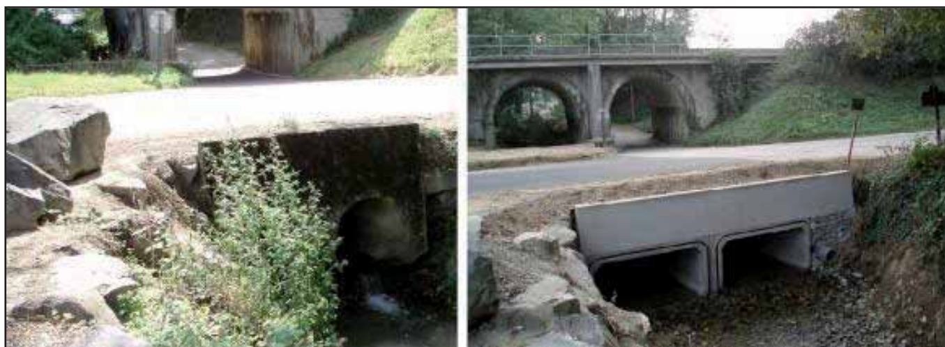
Ouvrage hydraulique (dalots ; avant/après travaux) en aval de la voie SNCF (Avenue Berthelot)
