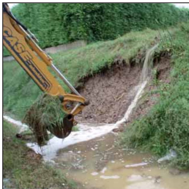
Evacuation du trop plein des eaux stagnantes au Nord de Prailles par des ruissellements, 2008
