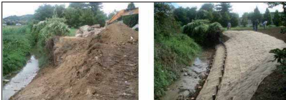
Stabilisation de berge par pieux et géotextiles
