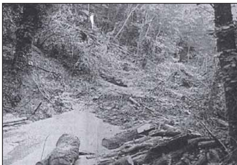
Glissement de couverture morainique au niveau de la route d'accès au camping le Daxia / Octobre 1993
