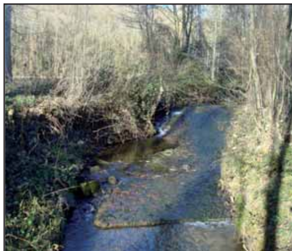
Seuil en galets maçonnés et confortement de berge en amont du pont Sylvie (pont amont)
